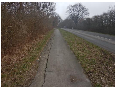
Abb. 1 Eingeschränkte Belagsqualität K 67 Sehmsdorf – Meddewade (links); L 90 Hoisdorf – Oetjendorf (rechts)
